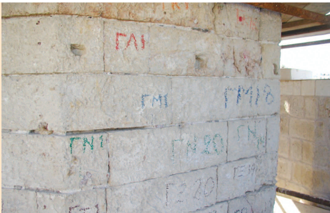
Λιθοδομή του φάρου των Χανίων. Με τη μέθοδο της γεωφυσικής έγινε αντιληπτό ποιες τεχνικές ακολουθήθηκαν για την τοποθέτηση των λίθων του, κατά τη διάρκεια εργασιών αποκατάστασής του που έγινε το 2006.
