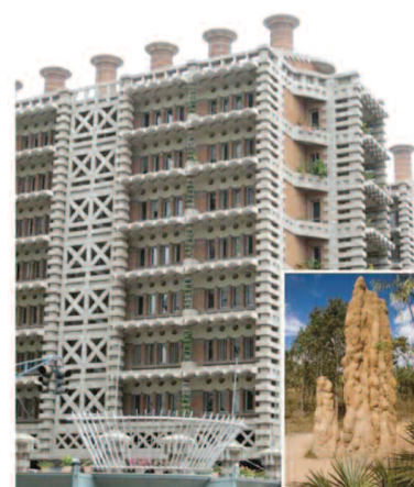
Παθητικό σύστημα εξαερισμού στο Eastgate
