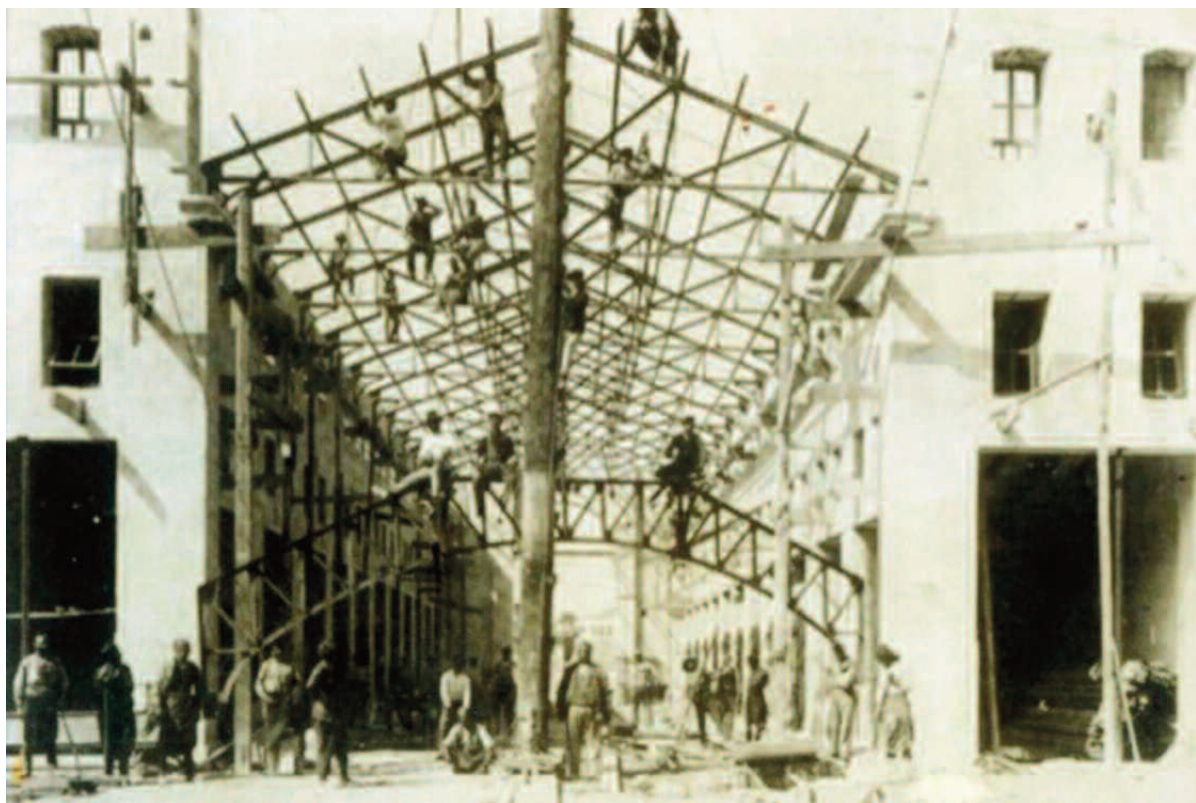
Κατά τη διάρκεια της κατασκευής της Αγοράς
