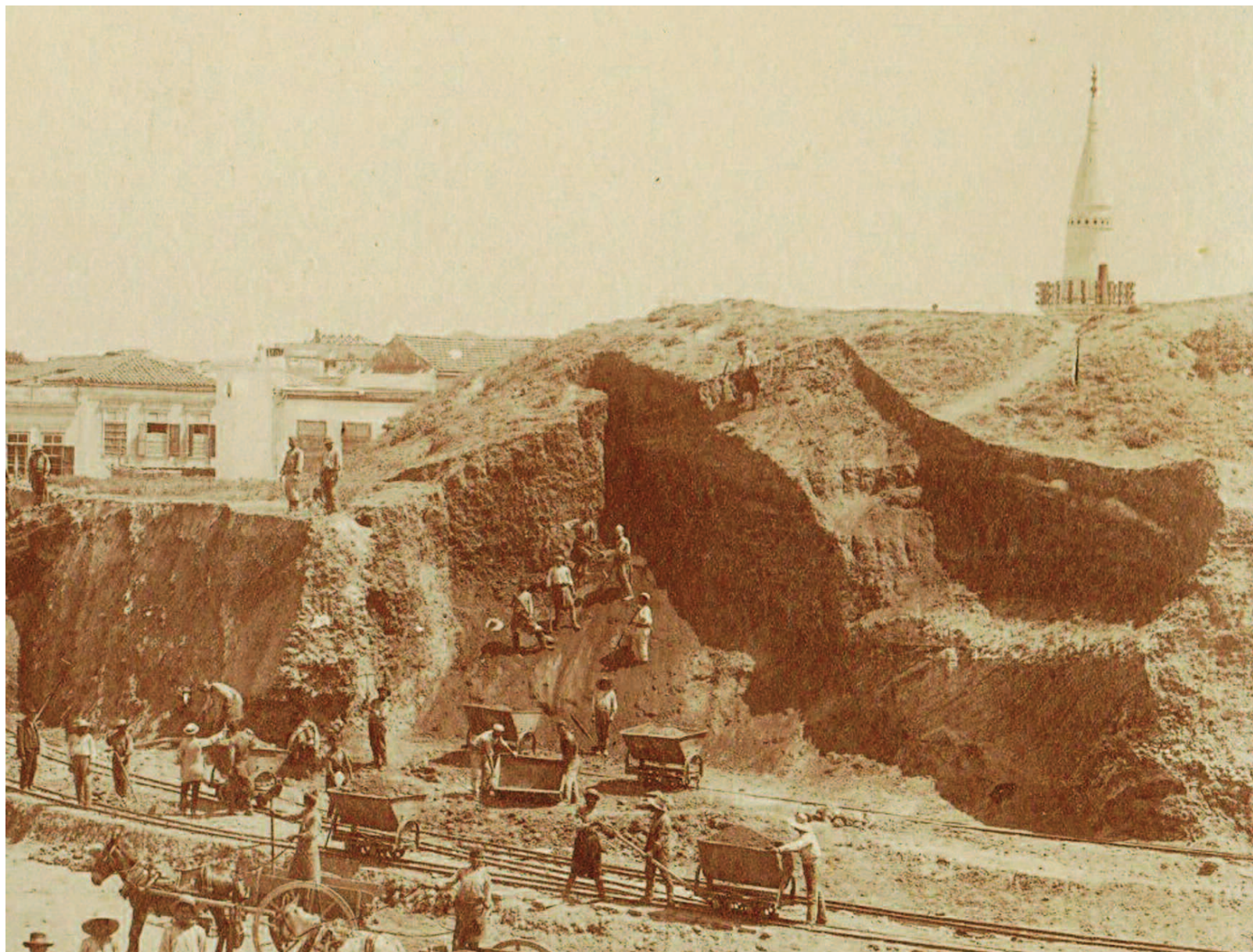
Από τις εργασίες στον προμαχώνα Piatta Forma όπου χτίστηκε η Αγορά.
