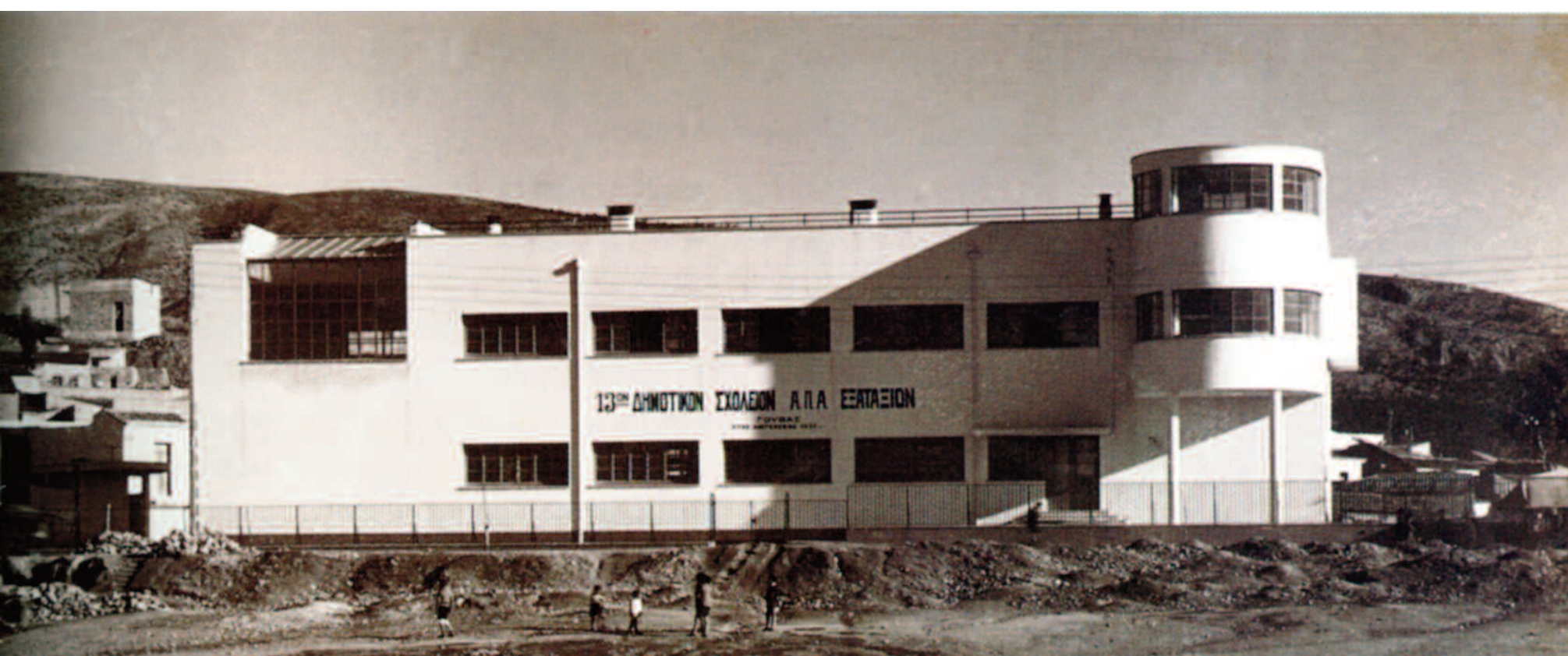
Ένα από τα μοντέρνα σχολεία της εποχής είναι και το δημοτικό της Γούβας στην Αθήνα, 1933. Κατά την διακυβέρνηση της χώρας από τον Ελευθέριο Βενιζέλο χτίστηκαν περισσότερα από 3.000 σχολικά κτίρια.
