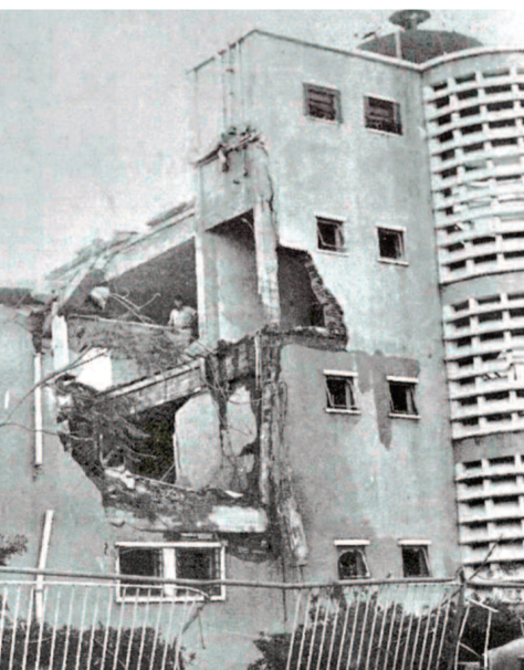
Το κατεστραμμένο κτίριο της Αστυνομίας Λεμεσού από τις ομάδες του Γ. Γρίβα
